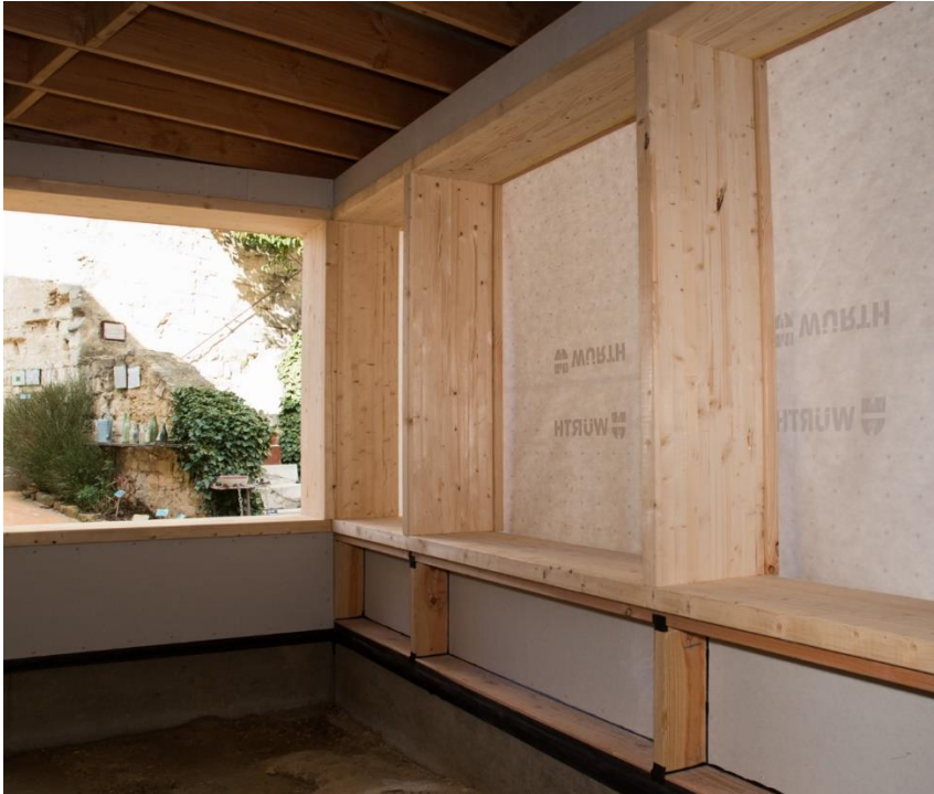
Figure 1 : pavillon d'accueil - vue intérieur en cours de montage
