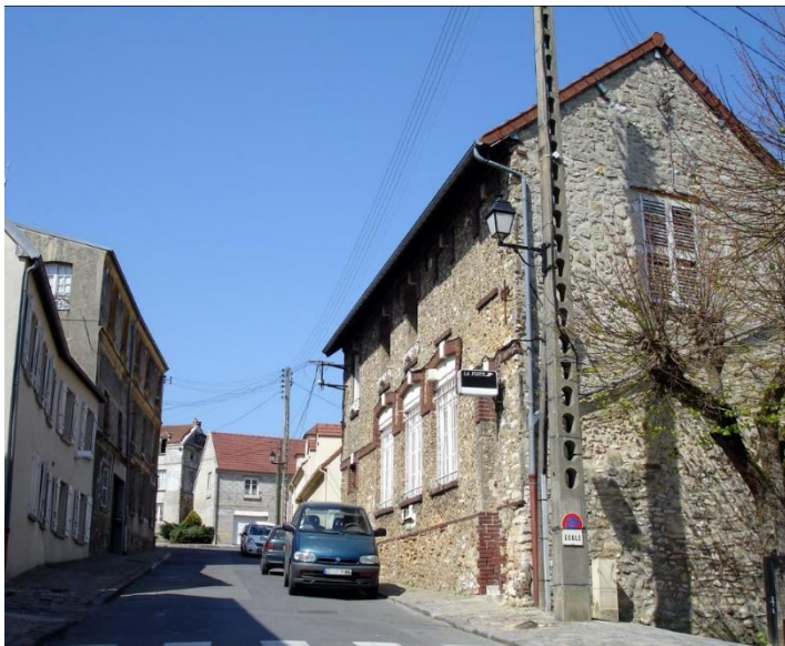
Le bâtiment du temps de La Poste
